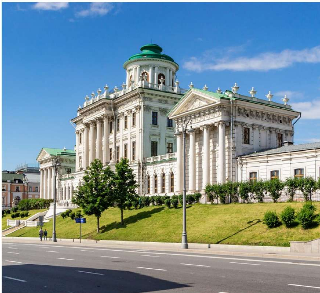
ДОМА ПАШКОВА. архитектор — БАЖЕНОВ В.И.
